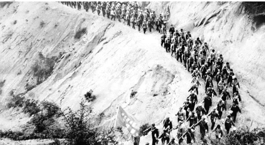
1958年成昆铁路正式开工
