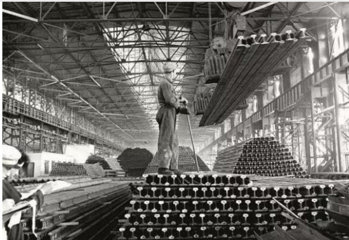
“一五”期间，鞍钢兴建的第一座大型轧钢厂生产能力迅速超过设计标准
